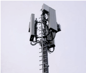
Netzausbau: Ein Mast als Mobilfunk-Basisstation auf dem Land in der Region am Tegernsee.
